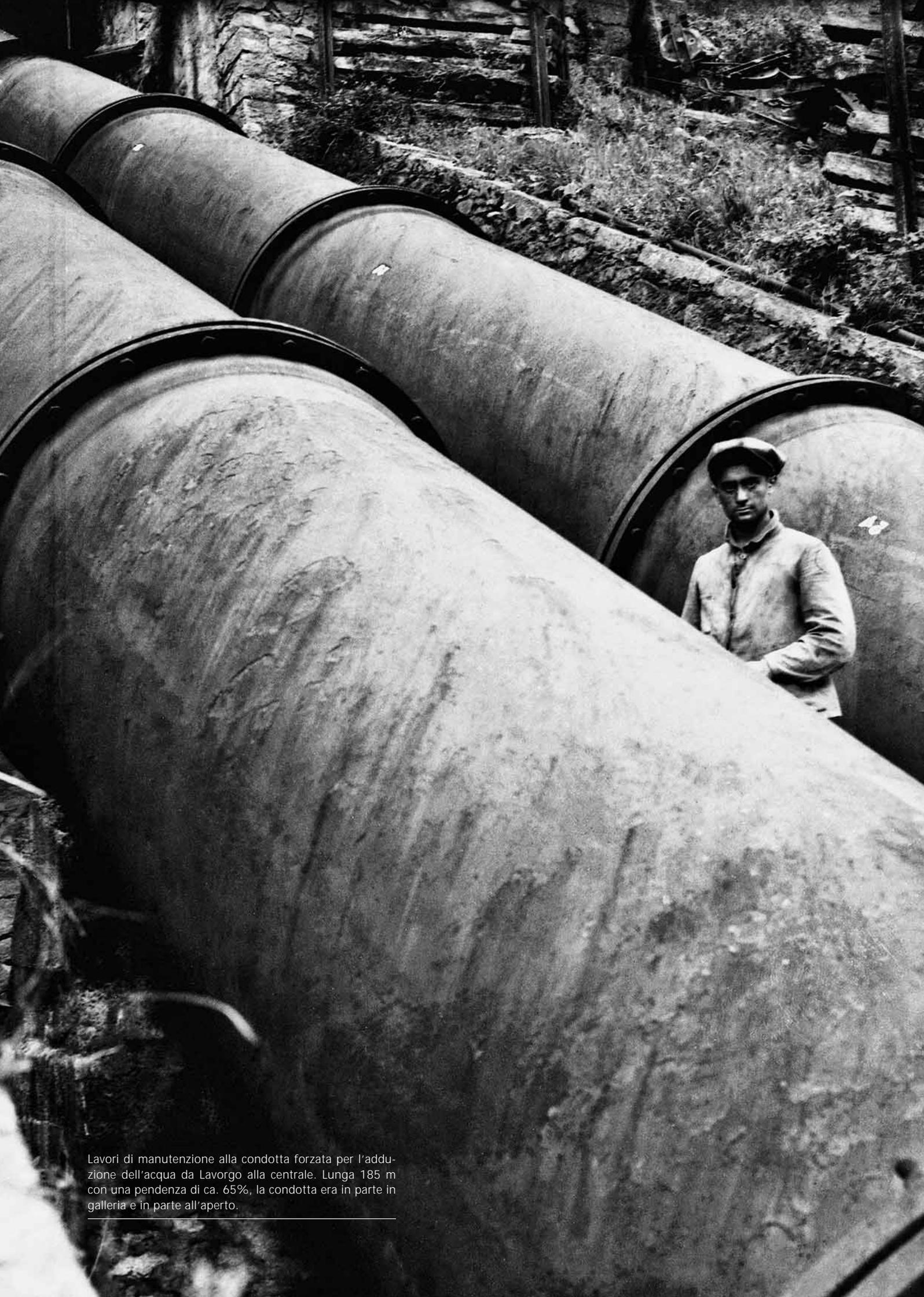
Lavori di manutenzione alla condotta forzata per l'adduzione dell'acqua da Lavorgo alla centrale. Lunga 185 m con una pendenza di ca. 65%, la condotta era in parte in galleria e in parte all'aperto.
