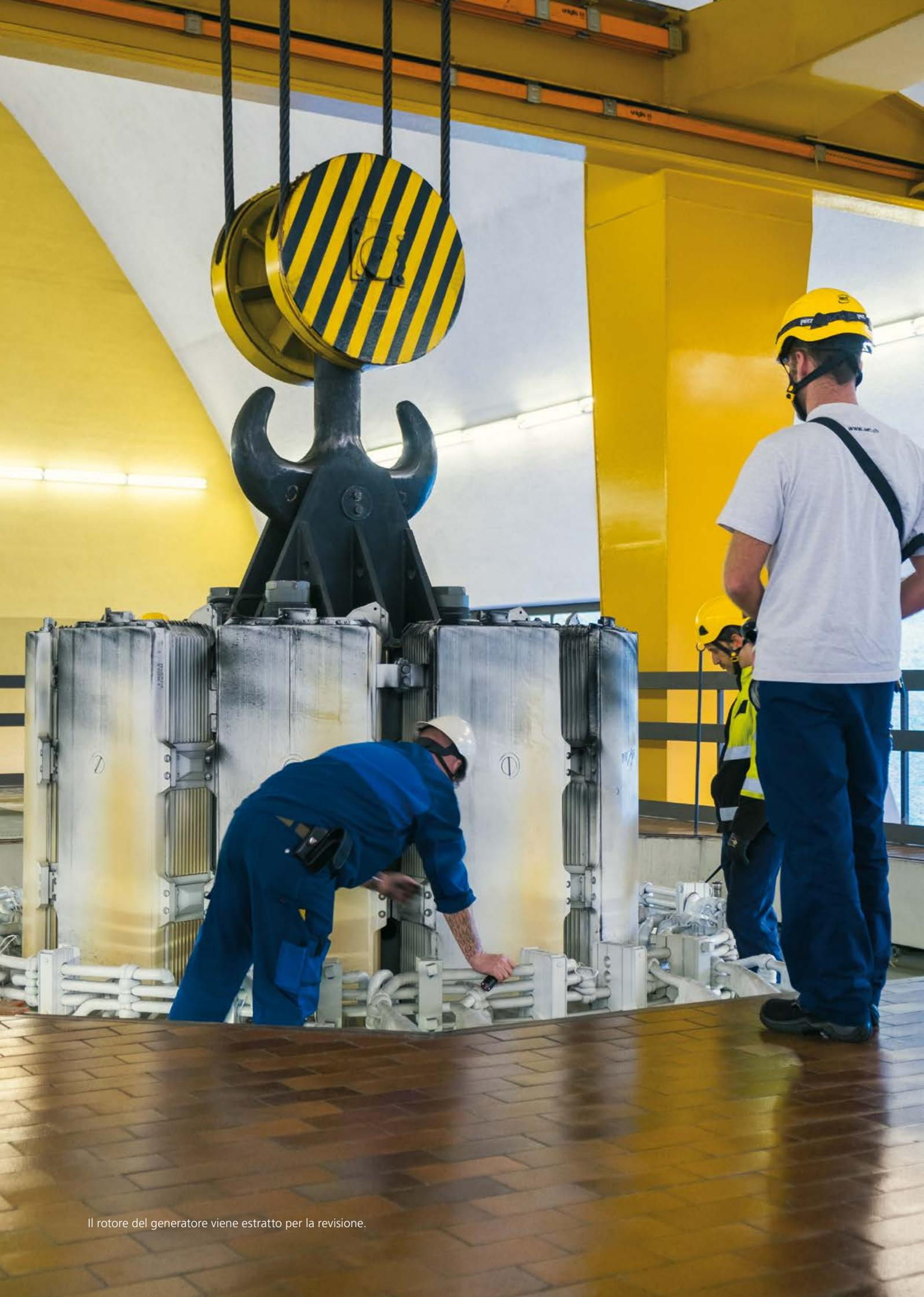
Il rotore del generatore viene estratto per la revisione.
