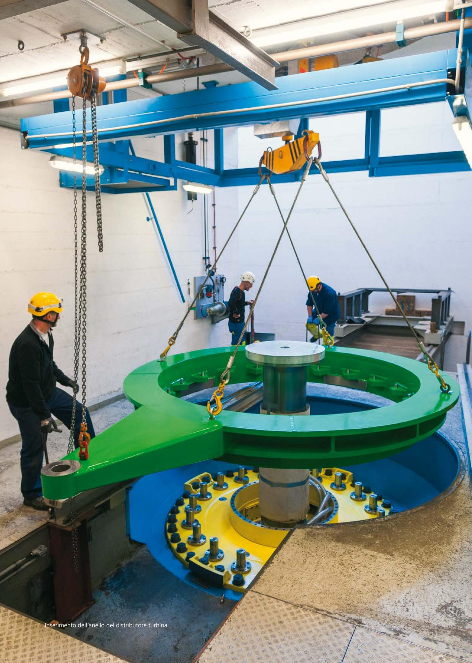
Inserimento dell'anello del distributore turbina.
