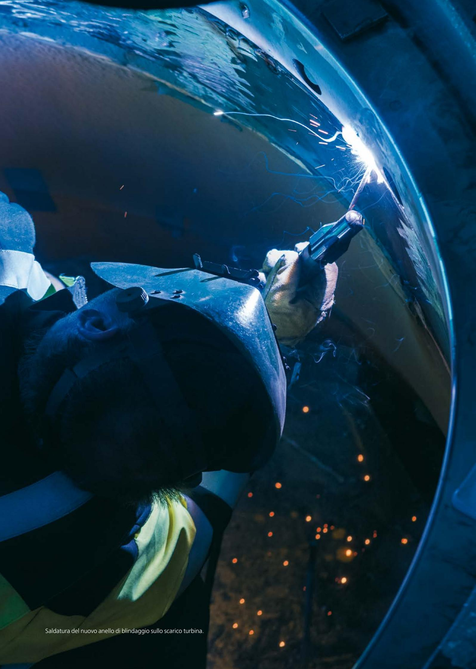
Saldatura del nuovo anello di blindaggio sullo scarico turbina.
