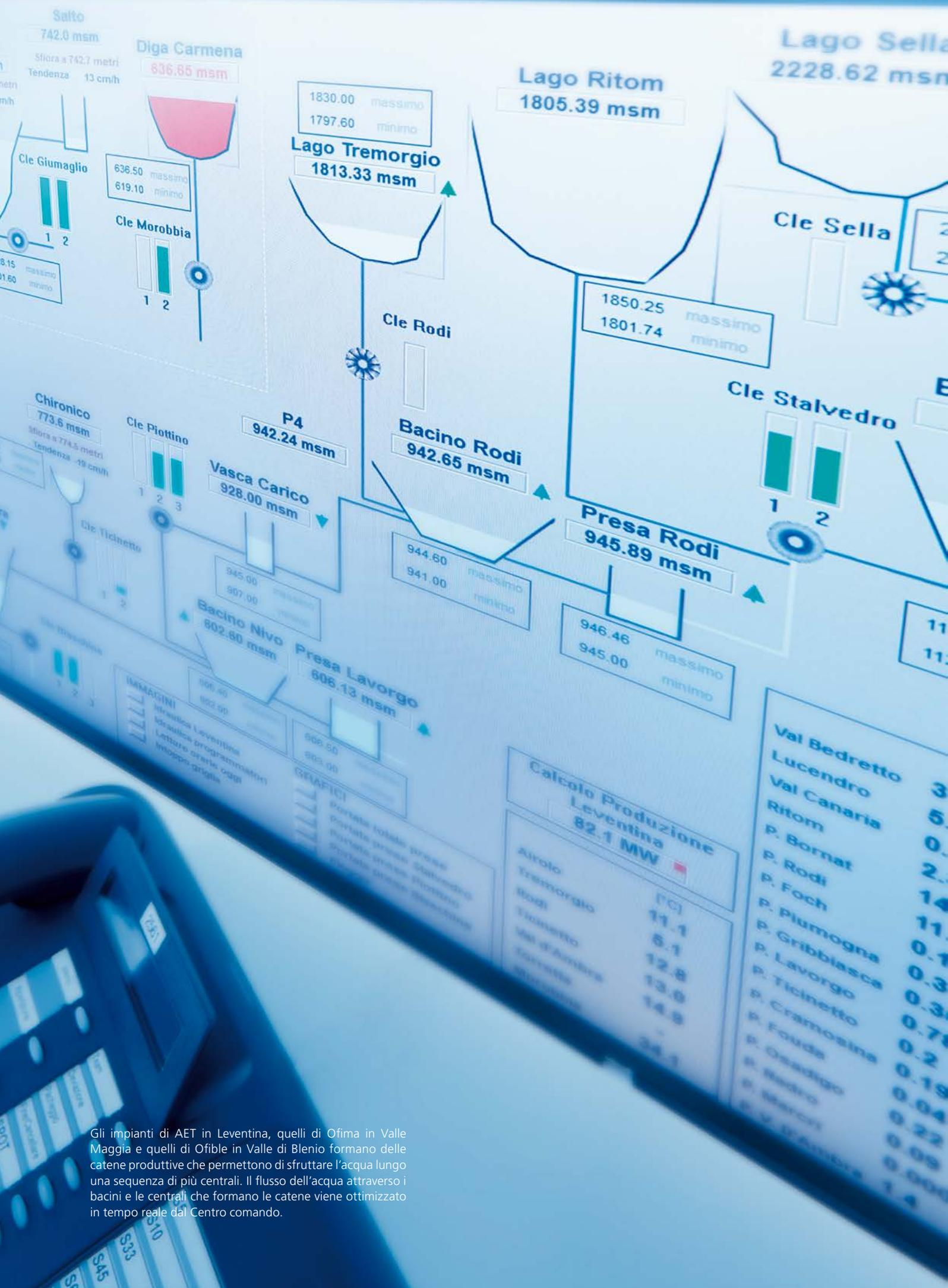
Gli impianti di AET in Leventina, quelli di Ofima in Valle Maggia e quelli di Ofible in Valle di Blenio formano delle catene produttive che permettono di sfruttare l'acqua lungo una sequenza di più centrali. Il flusso dell'acqua attraverso i bacini e le centrali che formano le catene viene ottimizzato in tempo reale dal Centro comando.
