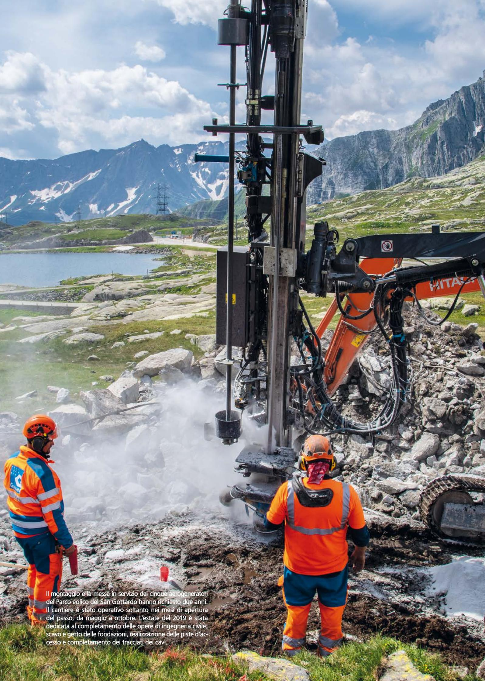
Il montaggio e la messa in servizio dei cinque aerogeneratori del Parco eolico del San Gottardo hanno richiesto due anni. Il cantiere è stato operativo soltanto nei mesi di apertura del passo, da maggio a ottobre. L'estate del 2019 è stata dedicata al completamento delle opere di ingegneria civile: scavo e getto delle fondazioni, realizzazione delle piste d'accesso e completamento dei tracciati dei cavi.
