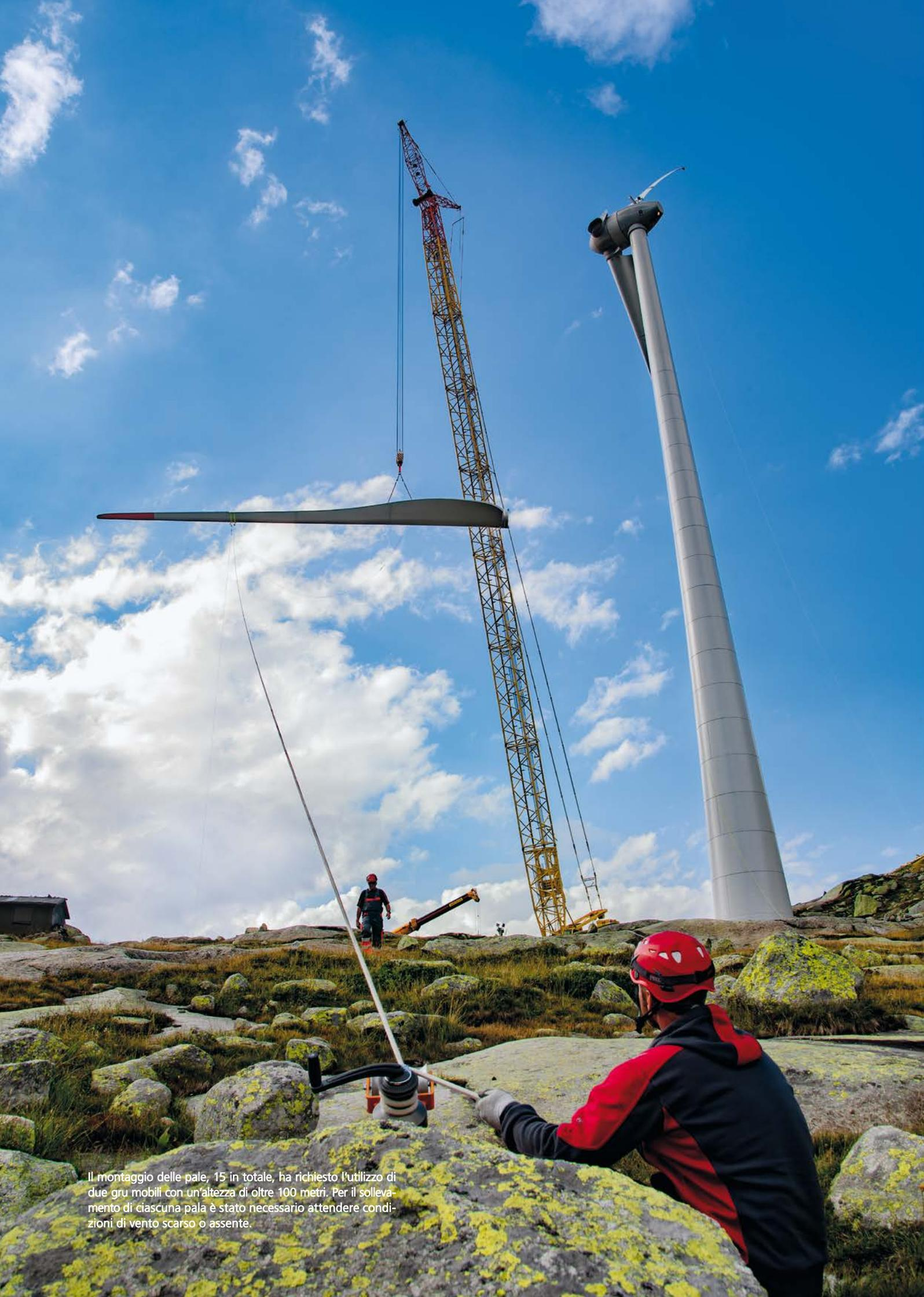
Il montaggio delle pale, 15 in totale, ha richiesto l'utilizzo di due gru mobili con un'altezza di oltre 100 metri. Per il sollevamento di ciascuna pala è stato necessario attendere condizioni di vento scarso o assente.
