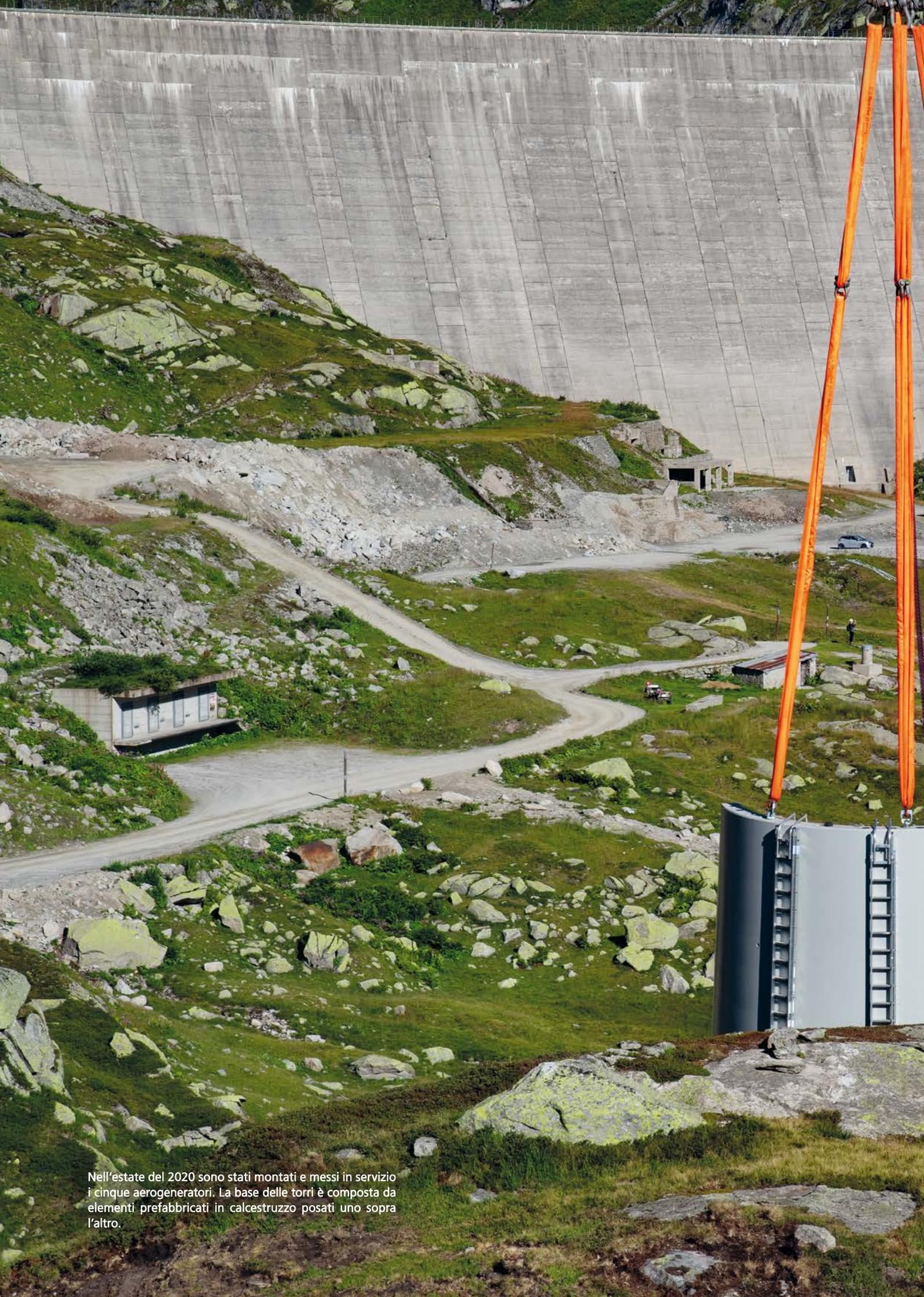
Nell'estate del 2020 sono stati montati e messi in servizio i cinque aerogeneratori. La base delle torri è composta da elementi prefabbricati in calcestruzzo posati uno sopra l'altro.
