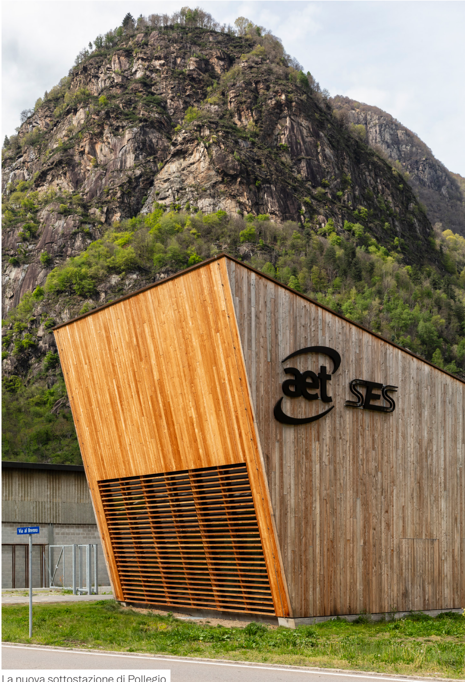
La nuova sottostazione di Pollegio
