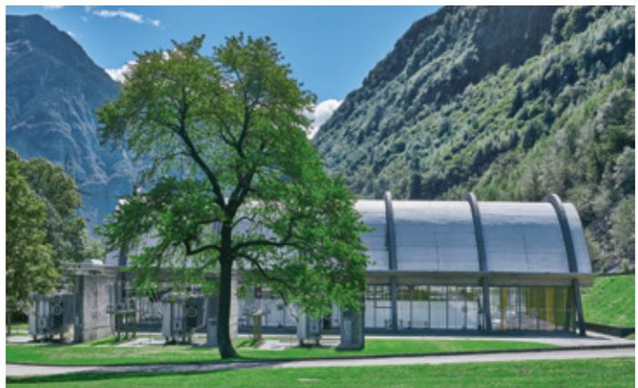
Realizzato tra il 1962 e il 1967, l'impianto della Nuova Biaschina è il più potente fra quelli attualmente gestiti da AET. Tra il 2016 e il 2019 le sue tre turbine sono state completamente rinnovate, consentendo un aumento del 9% della potenza complessiva.
