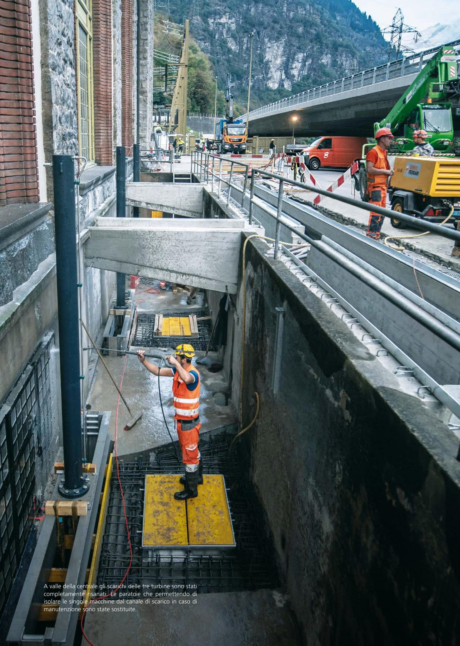
A valle della centrale gli scarichi delle tre turbine sono stati completamente risanati. Le paratoie che permettendo di isolare le singole macchine dal canale di scarico in caso di manutenzione sono state sostituite.
