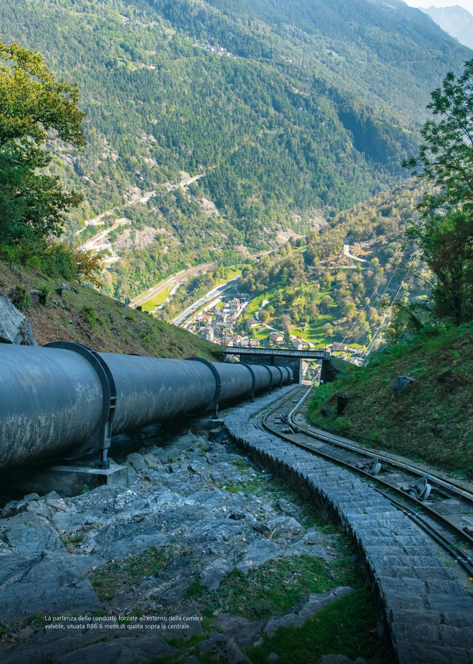
La partenza delle condotte forzate all'esterno della camera valvole, situata 886.6 metri di quota sopra la centrale.
