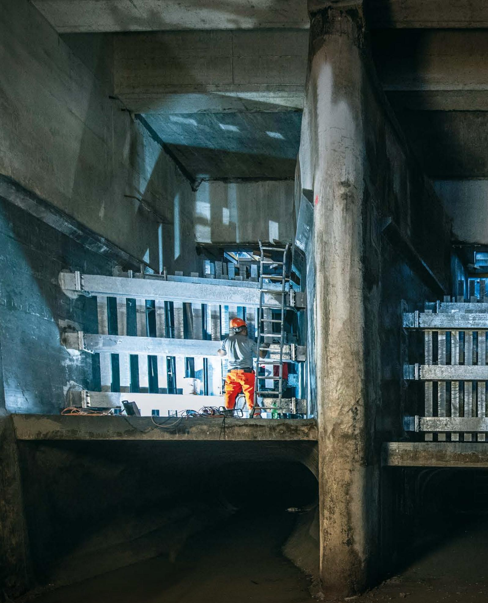
I binari presenti nell'opera di dissipazione a valle degli scarichi sincroni sono stati completamente sostituiti. Questi elementi permettono di smorzare la pressione dell'acqua in uscita dallo scarico sincrono prima di rilasciarla nel canale di scarico.
