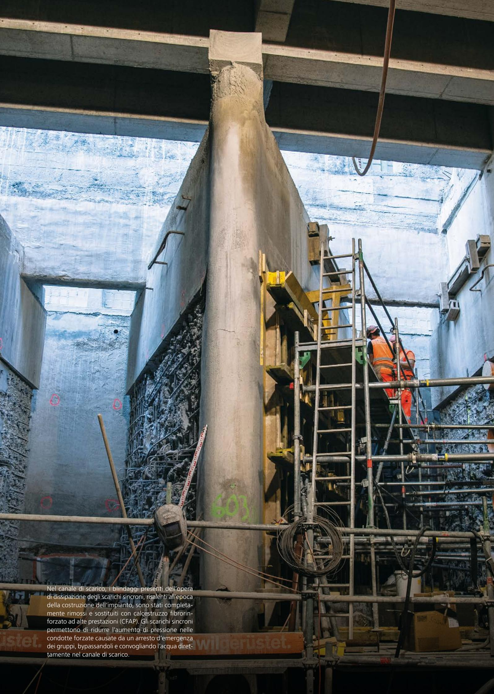
Nel canale di scarico, i blindaggi presenti dell'opera di dissipazione degli scarichi sincroni, risalenti all'epoca della costruzione dell'impianto, sono stati completamente rimossi e sostituiti con calcestruzzo fibrorinforzato ad alte prestazioni (CFAP). Gli scarichi sincroni permettono di ridurre l'aumento di pressione nelle condotte forzate causate da un arresto d'emergenza dei gruppi, bypassandoli e convogliando l'acqua direttamente nel canale di scarico.
