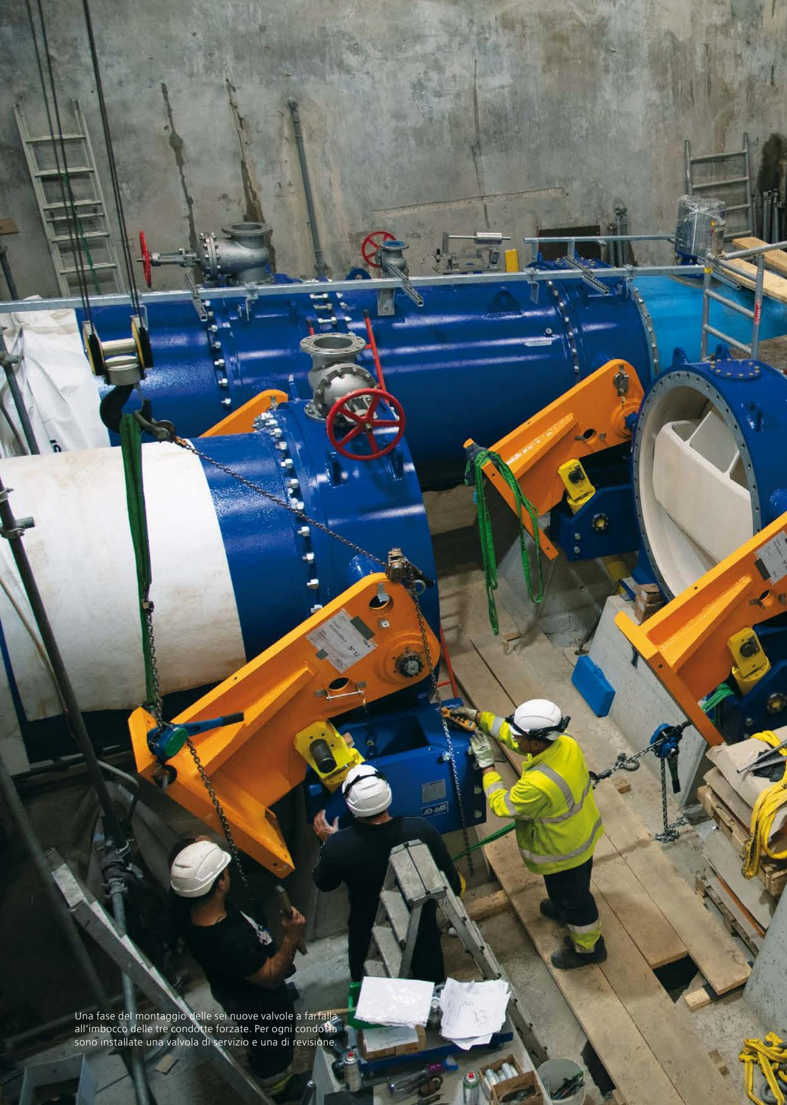
Una fase del montaggio delle sei nuove valvole a farfalla all'imbocco delle tre condotte forzate. Per ogni condotta sono installate una valvola di servizio e una di revisione.
