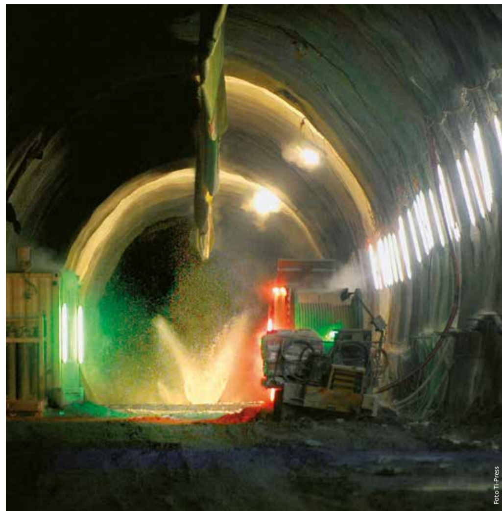
Scavo della Galleria di base del Monte Ceneri
